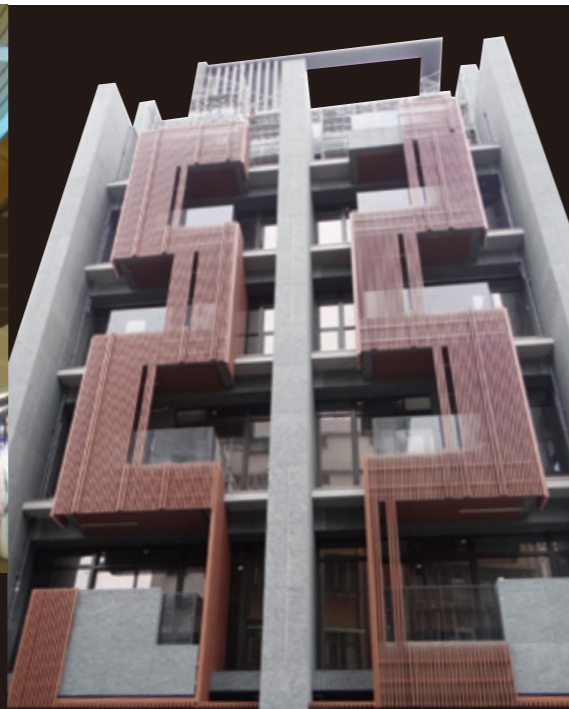
【マンション(外壁・ルーバー)】
