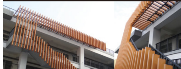
【学校(手すり)】 【台南市立図書館(外壁)】
