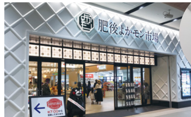
某駅商業施設（なまこパネル）
